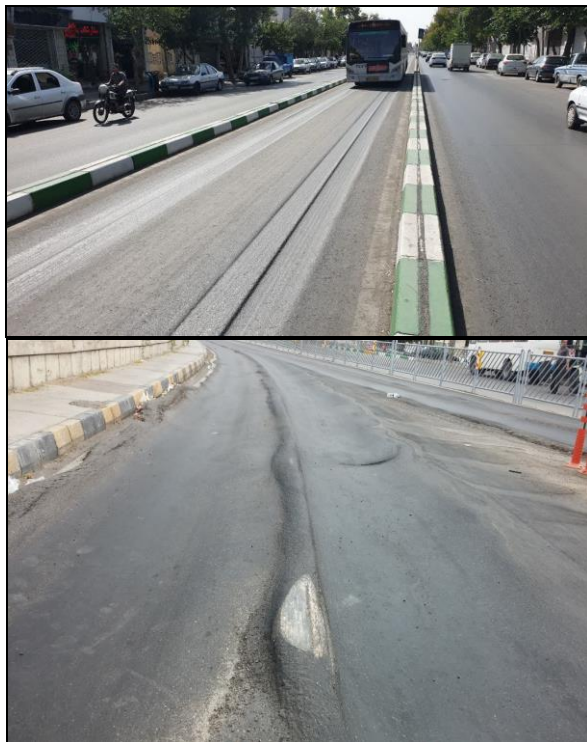
شکل ۱۰: شیارافتادگی ایجاد شده در خطوط BRT دارای آسفالت معمولی
