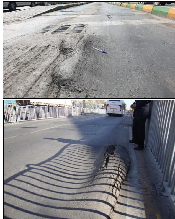
شکل ۱۰: شیارافتادگی ایجاد شده در خطوط BRT دارای آسفالت معمولی
