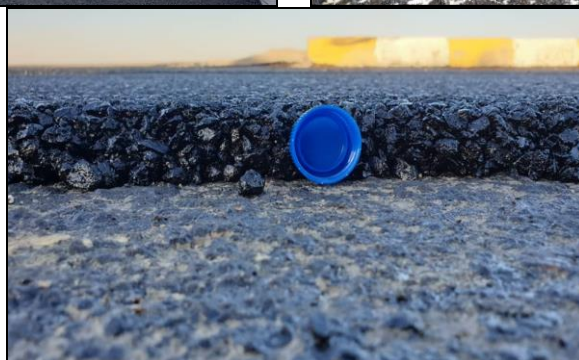
شکل ۱۳: اجرای آسفالت لایه‌نازک حاوی قیر لاستیکی (SPB) با دانه‌بندی باز در سال ۱۳۹۸، مشهد
