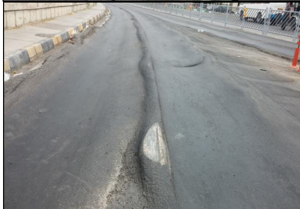
شکل ۱۰: شیارافتادگی ایجاد شده در خطوط BRT دارای آسفالت معمولی
