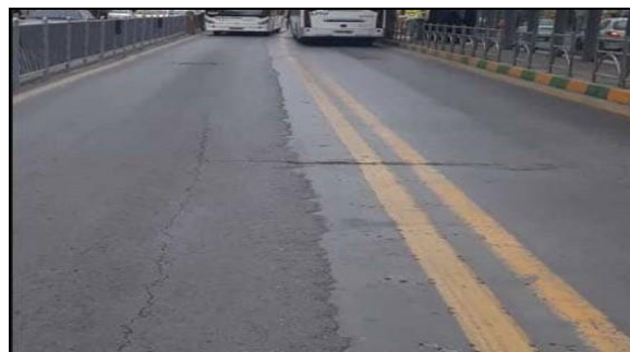
شکل ۱۱: خط ۱ BRT مشهد دارای آسفالت حاوی قیر لاستیکی (SPB) اجرا شده در سال ۱۳۹۷ بدون خرابی شیارافتادگی
