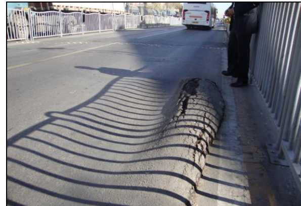
شکل ۱۰: شیارافتادگی ایجاد شده در خطوط BRT دارای آسفالت معمولی
